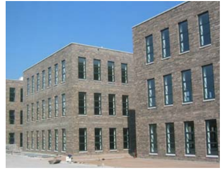
Kantoor Villas - Holland
